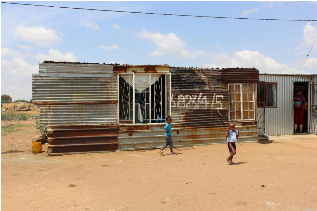
Das aktuelle Day Care Center – undichtes Dach und (noch) kein Zaun
